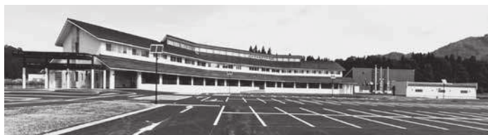
チップボイラーが設置された町立さわうち病院
