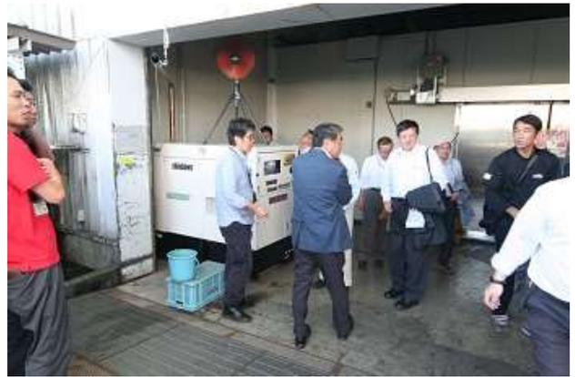
蓄冷材洗浄機を稼働させるために導入された発電機
