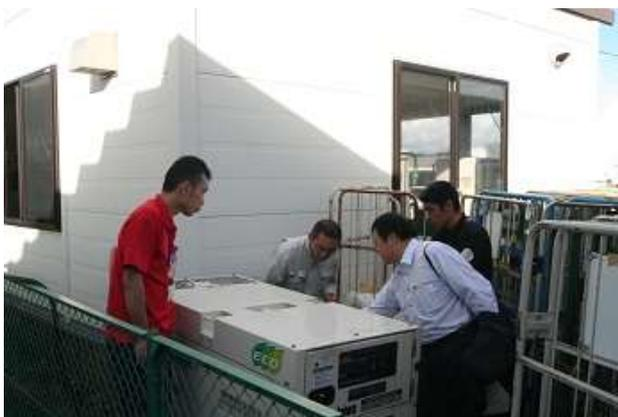
発泡スチロール減容機を稼働させる発電機
